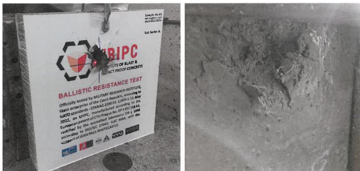
Obr. 1: Terč 01/A: Čelní strana (vlevo) a zadní strana (vpravo) první vrstvy sestavy po střeleckých zkouškách projektilem 12,7 × 99 API M8.
